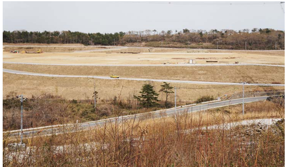
発電所北側造成地—廃棄物貯蔵庫用地
