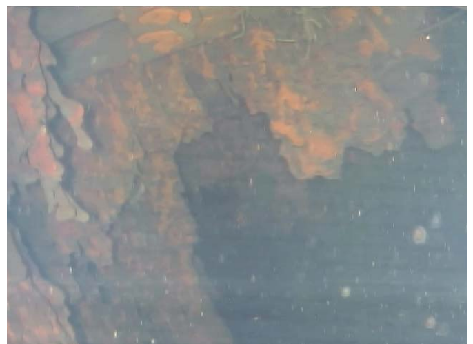
3号機の格納容器—冷却水の中 (潜水型ロボットで撮影) (TEPCO)
