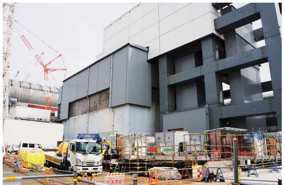
4号機の燃料取り出し用外側カバー
