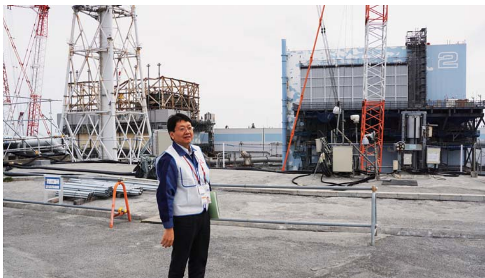
物見台から1号機（左奥）、2号機（右） 軽装で展望台に立てるようになった。（説明者は東京電力の木元さん）
