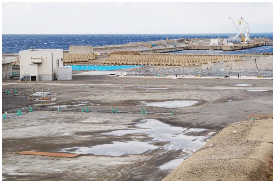
津波の影響を受けにくい大間発電所
