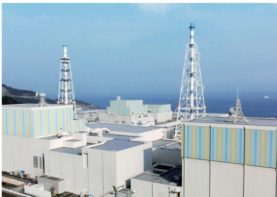
手前右が1号機、左が2号機、奥が建設中の3号機（中国電力提供）
