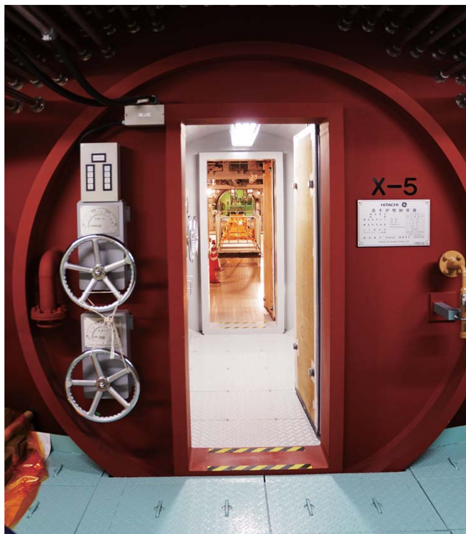
原子炉格納容器入口。分厚い壁の様子が分かる。
