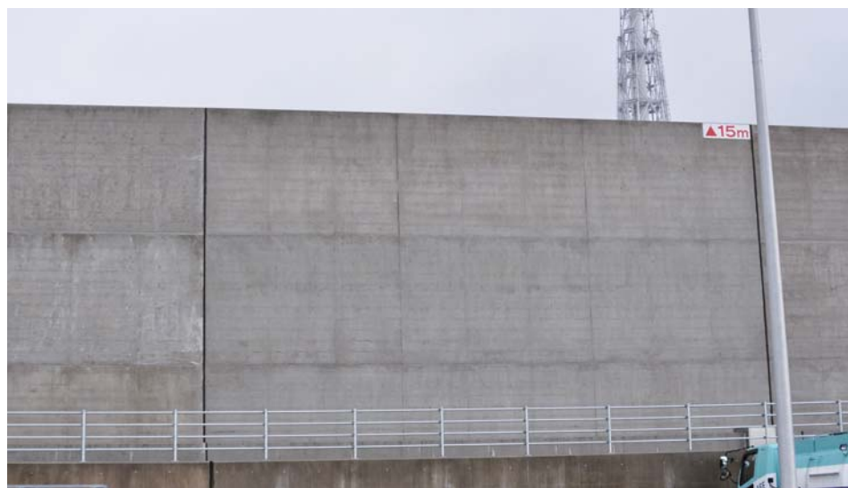
海拔15mの堤防1kmを設置
