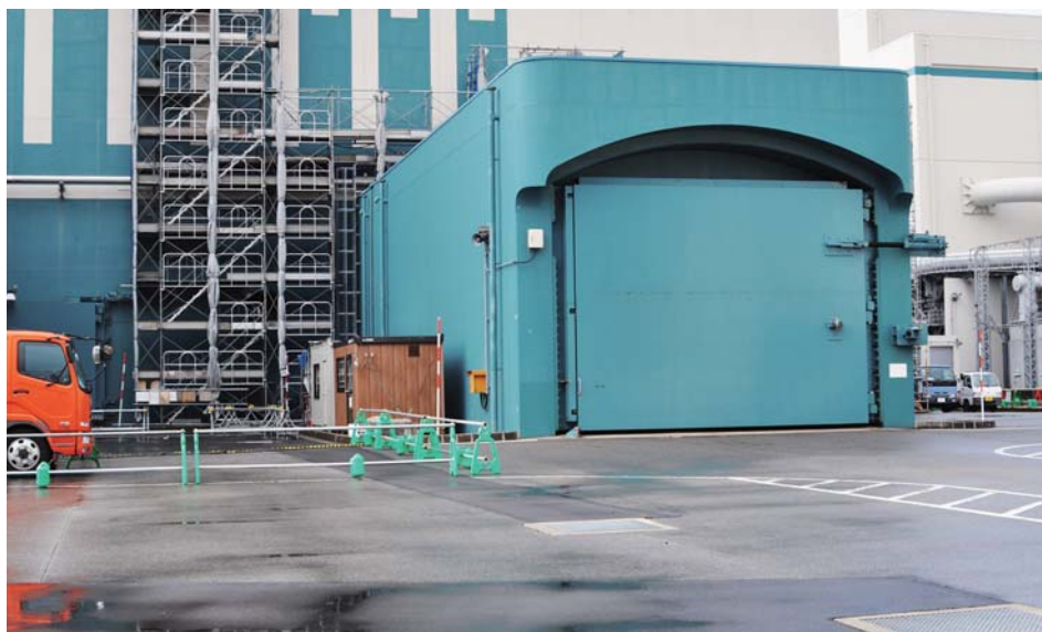
6号機の建屋に追加された水密扉
