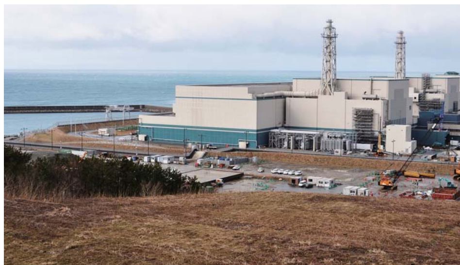
5~7号機は敷地が海拔12mで、3mの盛り土堤防
