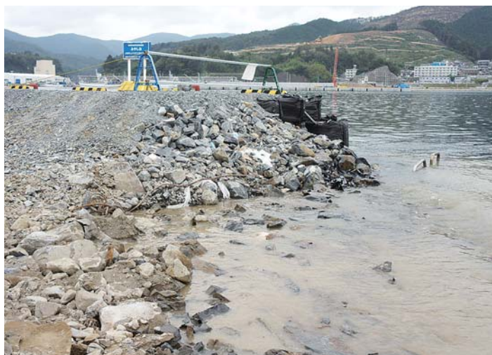
写真右側中程の海の中にある金属の枠が、大震災前の岸壁のもの。新しい岸壁がその上に造られた。
