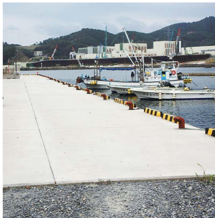
女川原子力発電所の近くの漁港では、80cm沈下した岸壁の上に、嵩上げた新しい岸壁が造られ、新しい漁船が係留されている。
