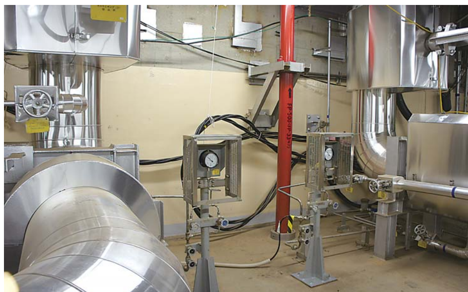
所員が敷設したケーブル（黒のライン）は当時のまま。電源ケーブルはかなり重い。
