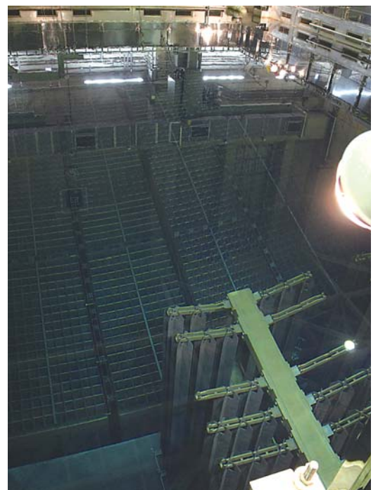
水の中に漬っているのは使用済燃料プールの燃料を入れるラック。手前のハンガーにぶら下がっているのは制御棒。
