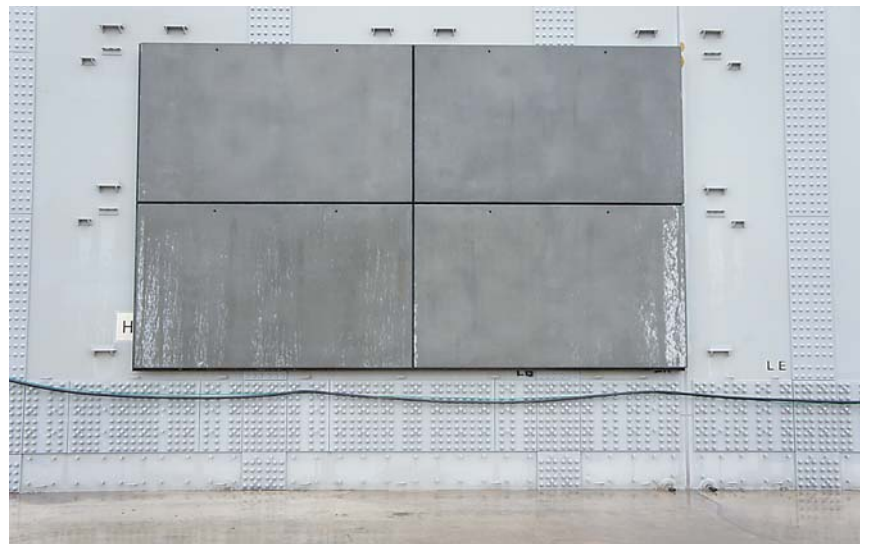
防潮壁の表面はさらにコンクリートパネルで補強
