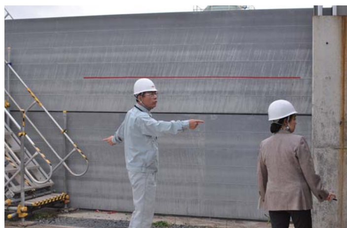
工事中だった新設の堰。頭の線の位置まで浸水
