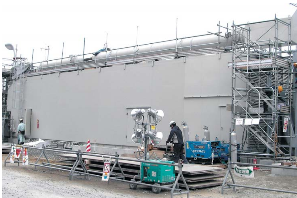
工事中の大型非常用ディーゼル発電機（東北電力提供）
