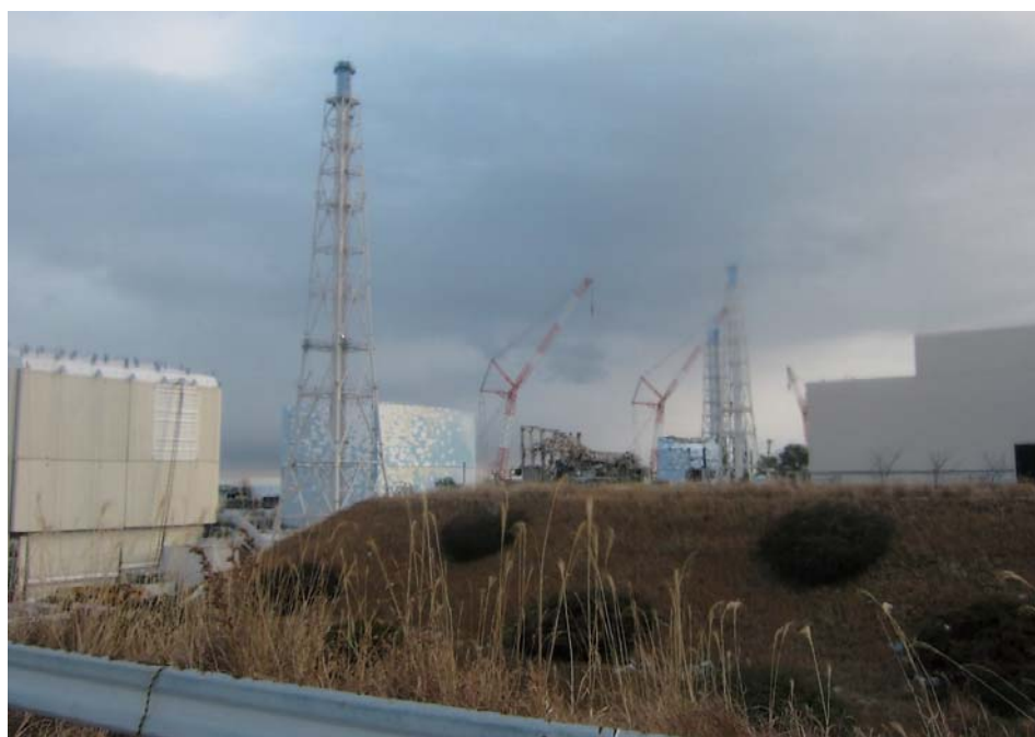
左から1、2、3、4号機。1号機は原子炉建屋にカバーを設置。(2012/1/9 東京電力提供)
