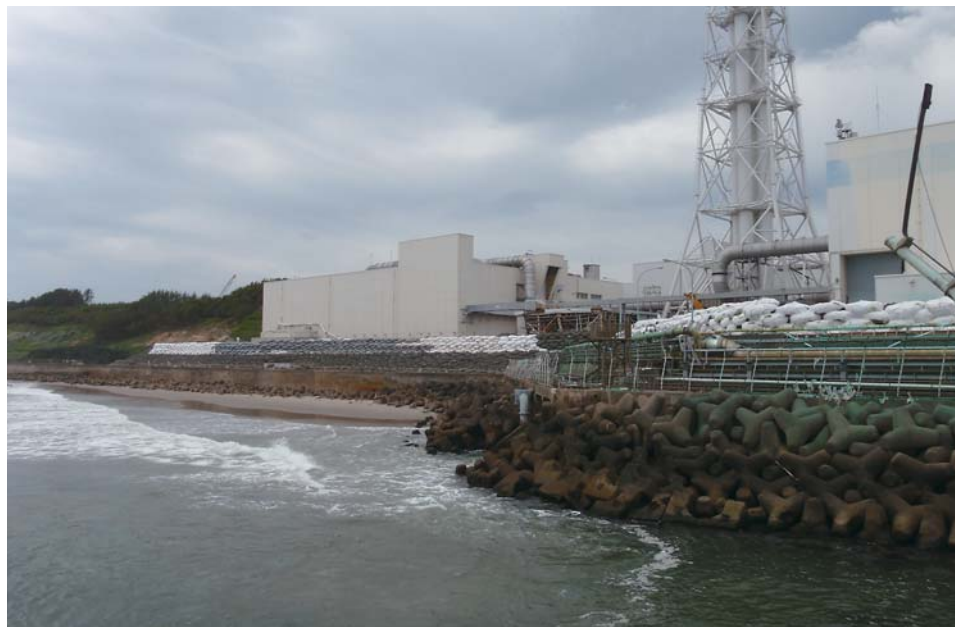
福島第一発電所の仮設防潮堤
