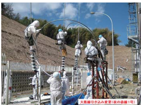
3月17日に外部電源引き込み完了
