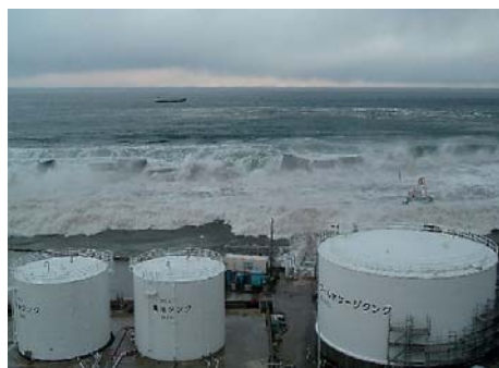
福島第一発電所に押し寄せた津波、堤防のケーソンもまるでサイコロ。
