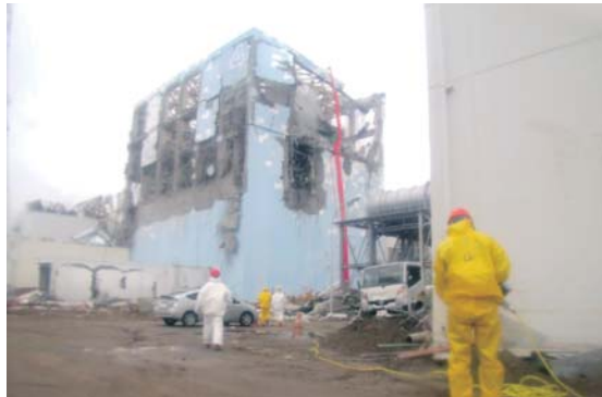
4号機の原子炉建屋。1、3号機に比べ外壁が残る
