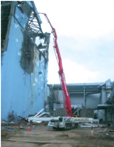
4号機の燃料プールにピンポイントで注入
