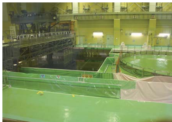
5号機の炉心上部 (原子炉建屋の中、左が燃料プール、右の円形が炉心上部)
