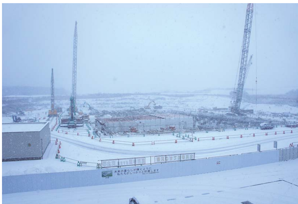
降雪の中でも工事が続けられています（2010/12/15撮影）
