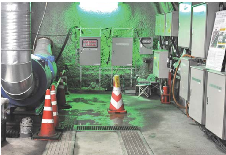
← 写真7：地下140m水平坑道の調査現場
