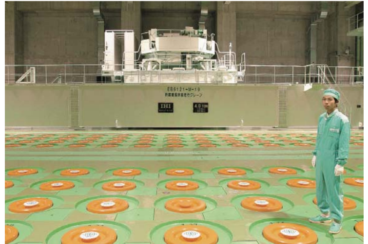
写真1：HLW貯蔵管理センター (職員の足下の日本原燃ロゴマーク印のピットにHLW固化体が8本ずつ挿入・保管／日本原燃提供)
