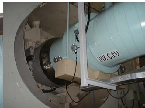
▲修理完了の2次系配管 (2007年5月：原子力機構提供)
