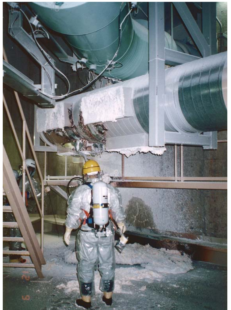
ナトリウム化合物が床に堆積（1995年12月：原子力機構提供）
