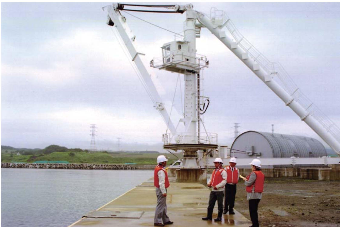
防波堤はすでに準備工事段階で完成
