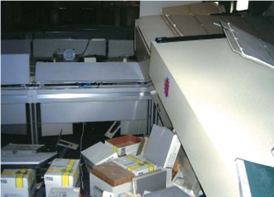
事務本館内の書類ラックが転倒
