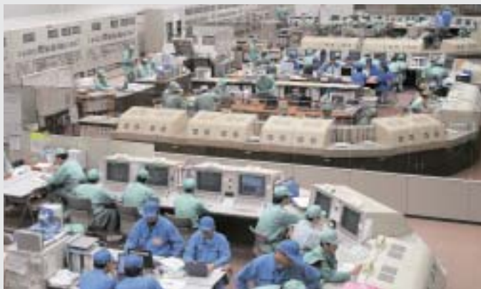
試験中の再処理工場の中央制御室(日本原燃写真提供)
