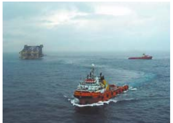
写真3 輸送中の春暁中央施設土台
