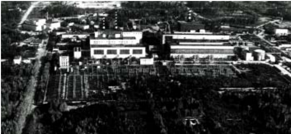
右側の建物がBN-600、左側は廃炉となったRBMK炉 (BN-600パンフレットより)
