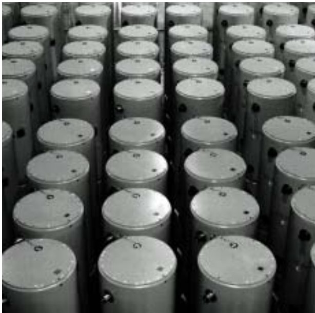
高温ガス炉THTR/ユーリッヒAVRの使用済燃料の貯蔵 (BZA社バンフレット)
