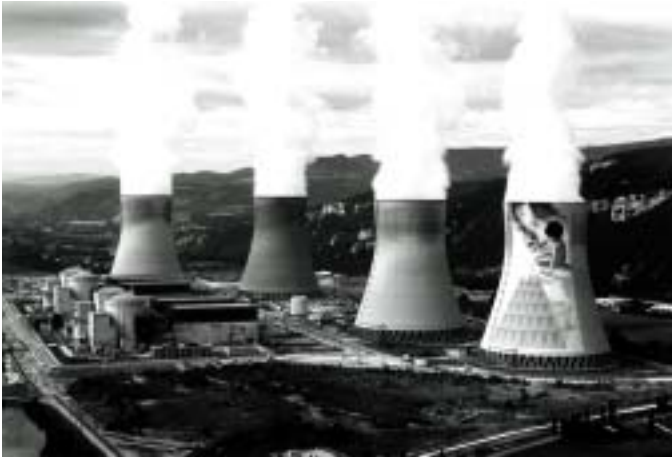
クリュアス原子力発電所（フランス）
