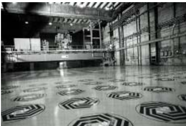
ガラス固化体貯蔵施設 (COGEMAのロゴマークが付いているところに入っている。) (COGEMAパンフレットより)
