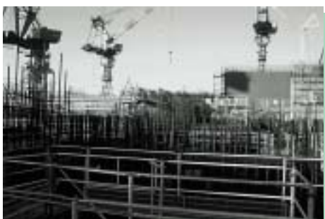
鉄筋が立ち並ぶ再処理施設分離建屋の地上階付近
