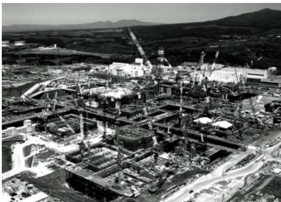
クレーンが林立する再処理工場建設現場
