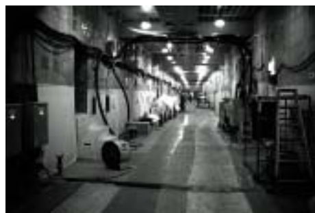
分離建屋地下3階の抽出塔、分配塔セル付近の通路
