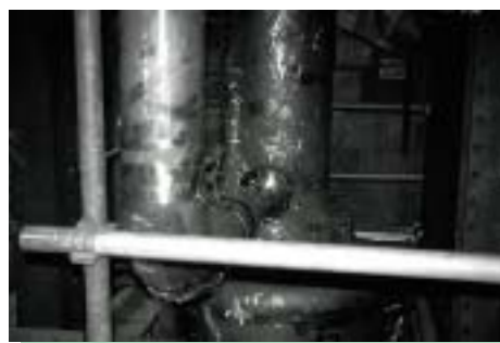
分離建屋に据え付けられたパルスカメラ
