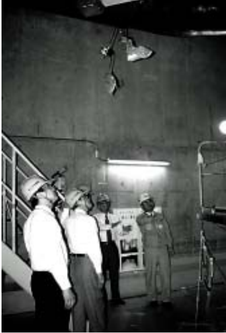
頭上の配管に取り付けられた温度計から2次系ナトリウムが漏れた(もんじゅ)
