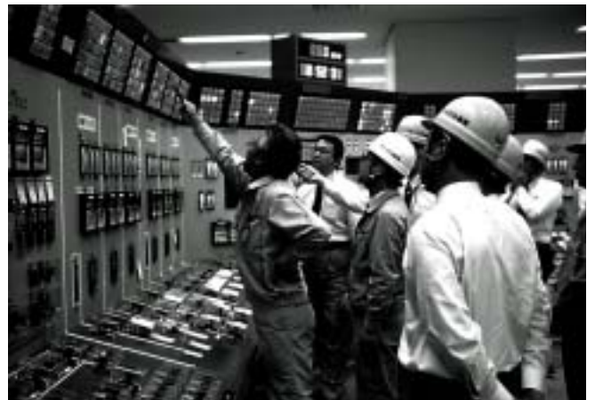
ナトリウムが漏れた時にアラームが鳴った位置を示している（「もんじゅ」コントロール・ルーム）
